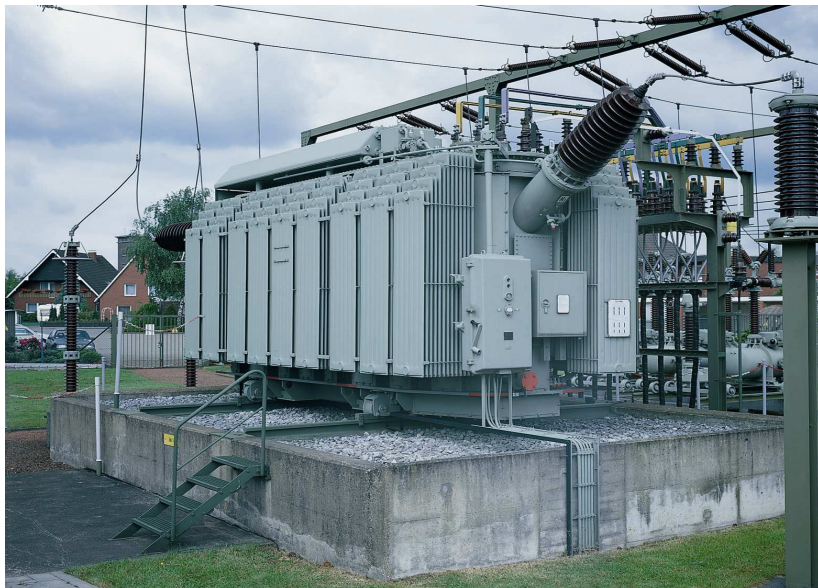
Obr. č. 1 - nahoře Zakrytí záchytné vany transformátoru rošty a kamenivem.
