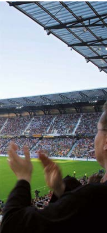
Oben: Stadien Salzburg, Innsbruck, Klagenfurt Patentiert, modulare Tribünensysteme zur EM 2008 geliefert und teilweise montiert
