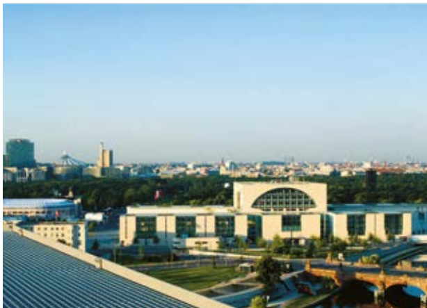
Oben: Hauptbahnhof Berlin Dachbelegung mit Pressrosten im Bereich der Technikzentrale
